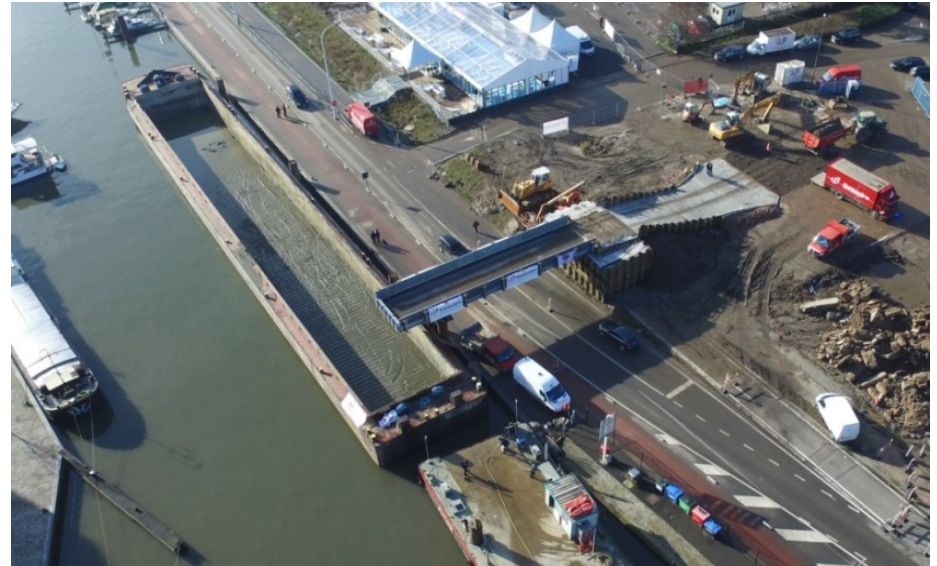
Grondafvoer – levering bouwmaterialen Hasselt
